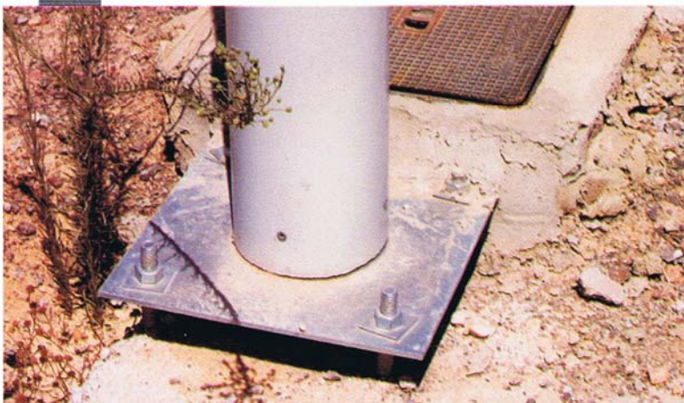
Detalle del anclaje
